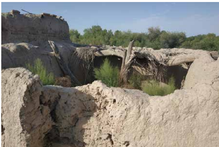
Рис. 4.326. Мавзолей Кошкар-Ата. Балки-покрытия в ограде
